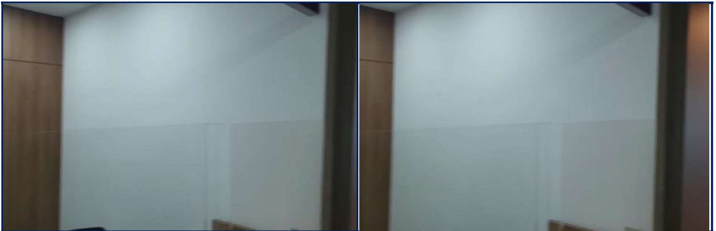
Local antes da instalação
